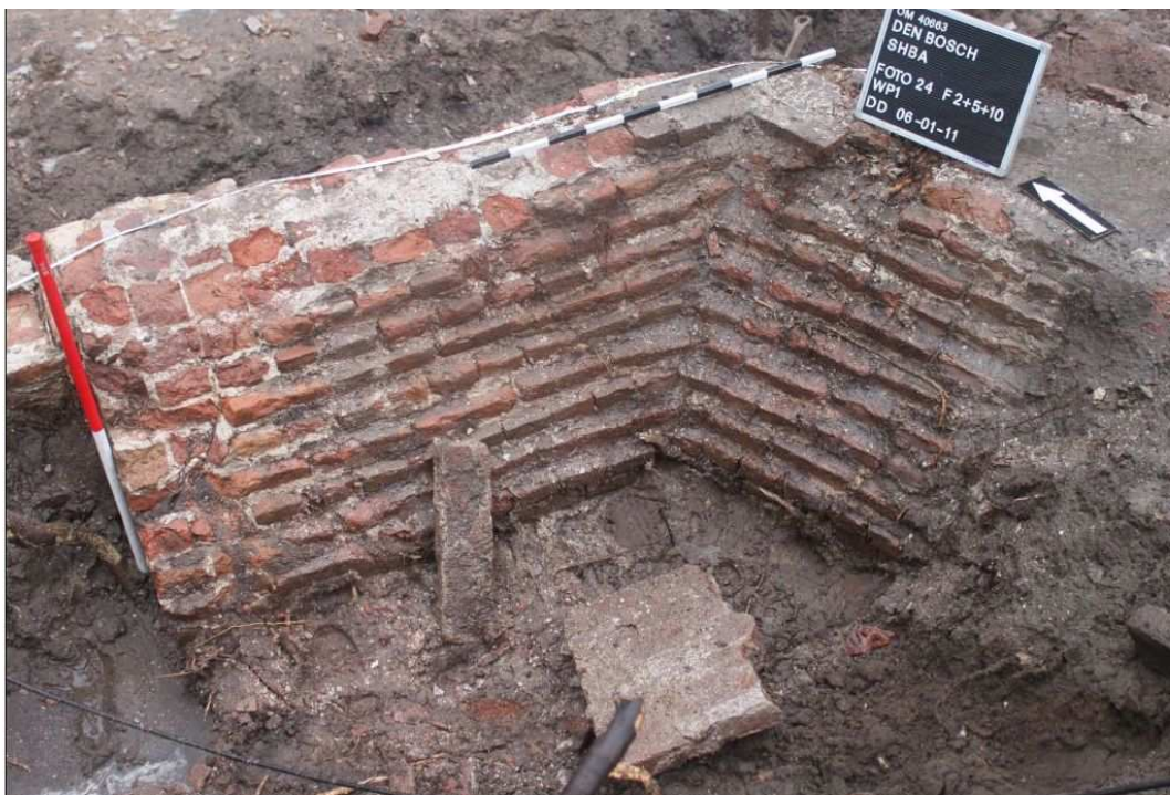
Figuur 4: Zicht op de binnenzijde van het bastion in werkput 1, met daarin een van de steunberen (F6), de oude muur (F5) en de rollaag (F1) duidelijk zichtbaar.
