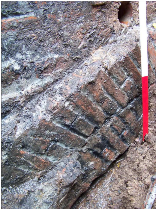
Figuur 6: Detailopname van een van de funderingsbogen aan de onderzijde van de schildmuur (F20).
